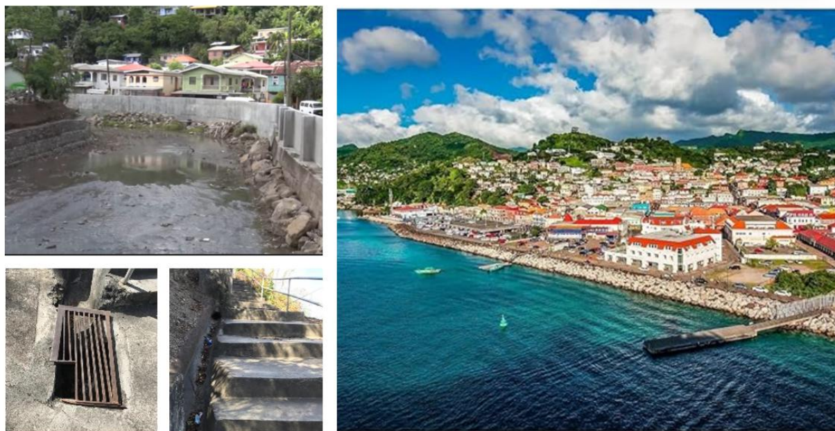
Ilustración 76 Estructuras ante las inundaciones en St. George's Fuentes: GIS Grenada, ALBA-TCP y Elaboración propia
